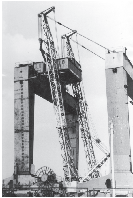
Монтаж козлового крана на спецпричале завода «Атоммаш».
