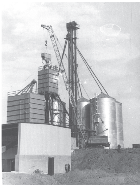
Монтаж оборудования комбикормового завода в совхозе «Братский» Ростовской области
